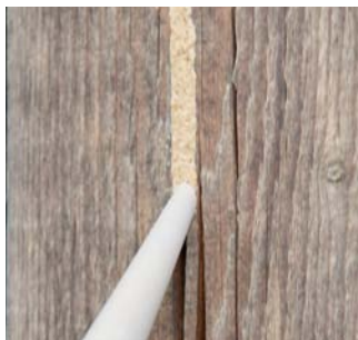
Füllung eines Schwindrisses in einem Fachwerkbalken
