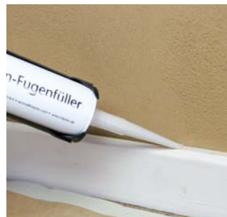
Fugenfüllung mit natur-weiß an einer Sockelleiste
