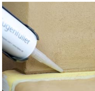
Fugenfüllung mit natur-braun an einer Fensterbank
